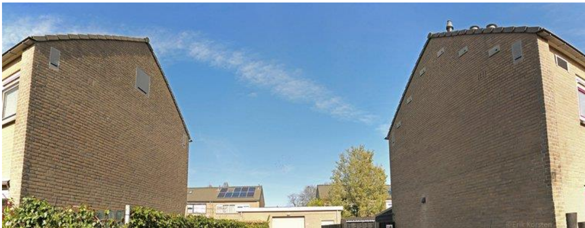
Inbouwkasten voor vleermuizen (spleet onderzijde) en gierzwaluw (ovale opening) hebben een potentie om weer in verblijfplaatsen te voorzien, maar meer kennis over de werking is dringend nodig. (Bron: Erik Korsten)
